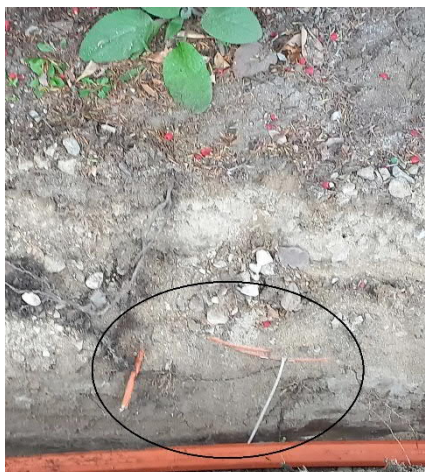
1- Overgravet fiberrør i JHA-61. Man ser stumpen og kanten af rørslyngen, som holdes sammen med en lys strip.
